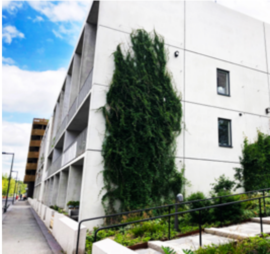
En grön vägg förankras mot byggnaden med hjälp av vajrar eller nät. Foto: Veg Tech AB
